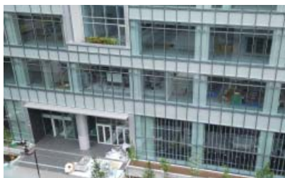
理工学部新校舎 (玄関付近)
